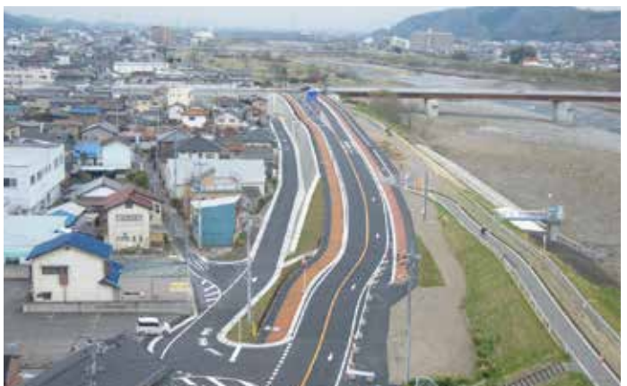
街路築造工事
