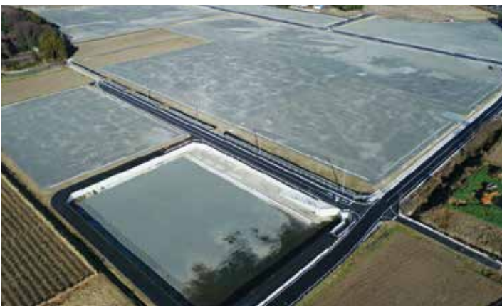
某工業団地造成
